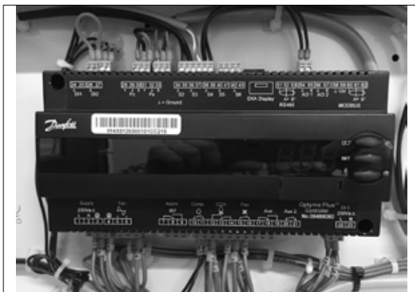
Abbildung 4: Normale Verdrahtung
