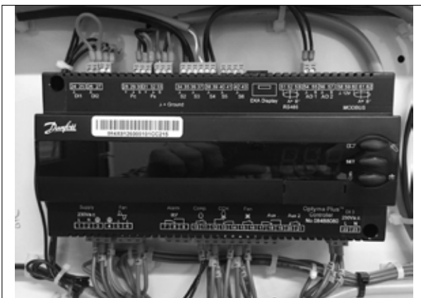
Rysunek 4: Normalne okablowanie
