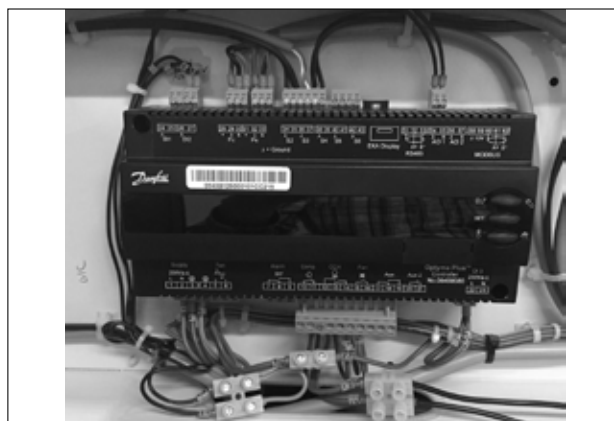
Abbildung 5: Vorübergehende Verdrahtung
